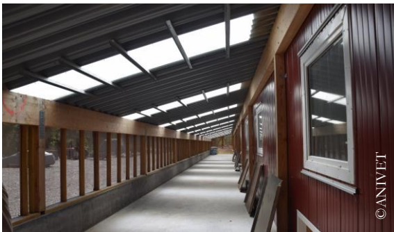
Veranda con pareti in materiale a maglia fine e tettoia con pannelli oscuranti e trasparenti alternate.
