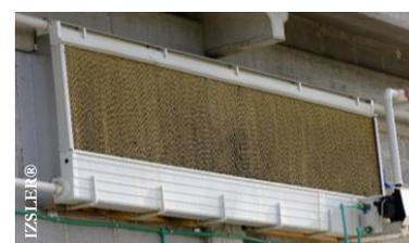
Figura 2. Sistema di raffreddamento (unità esterna).
