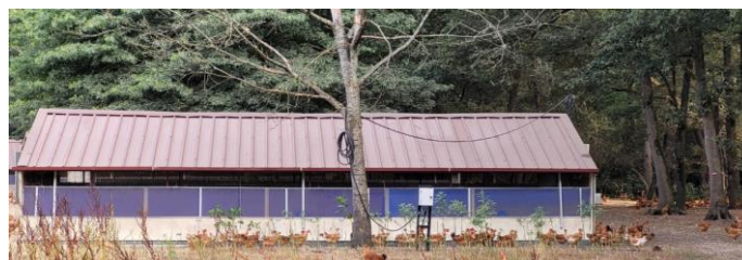
Rys. 2. Długi bok kurnika z oknami, widoczny jest również zasilanie.
