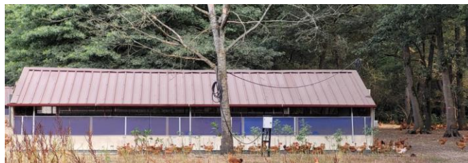
Abb. 2. Längsseite des Stalls, mit Lichtband, auch die Stromversorgung ist sichtbar.
