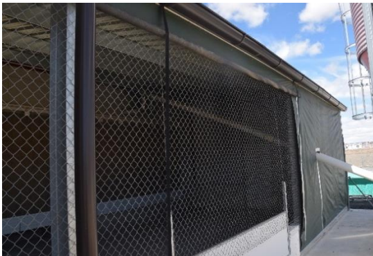
Figure 4: La cortina en la parte trasera (donde pasa la tubería) está cerrada para proteger del sol, mientras que la cortina delantera (donde se ve la malla de alambre) está abierta. Fuente: ANIVET.
