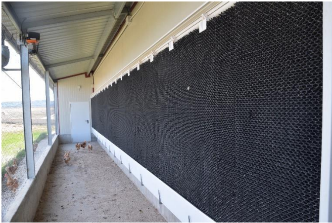
Abbildung 2: Kühlpads, betrachtet von der überdachten Veranda außerhalb der Scheune. Quelle: ANIVET
