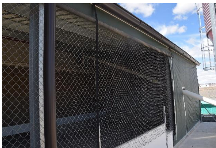
Фигура 4: Завесата отзад (където минава тръбата) е спусната, за да предпазва от слънцето, докато завесата отпред (където се вижда телената мрежа) е отворена. Източник: ANIVET
