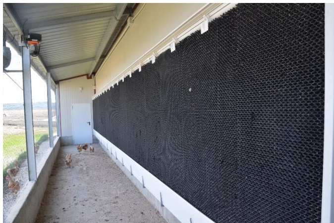
Фигура 2: Охлаждащи подложки, видяни от покритата веранда пред обора. Източник: ANIVET
