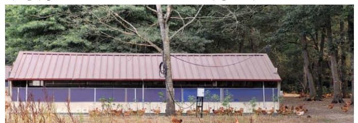
Fig. 2. Lateral largo de la nave, con ventanas, también se puede ver el suministro eléctrico.
