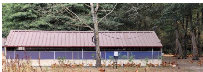
Fig. 2. Lato lungo del capannone, con finestre, è anche visibile il generatore di corrente.
